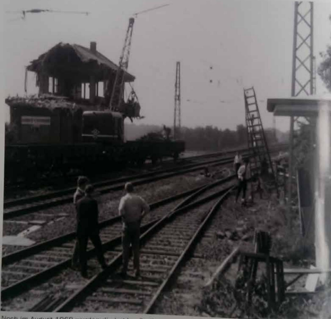
Noch im August 1968 wurden die beiden Stellwerke Iwf und Io abgebrochen. Hier links im Bild der Abbruch des Stellwerks Iwf, das auf der Unterführung der Isselhorster Straße, in der Mitte zwischen den Personen- und Gütergleisen, gestanden hat.
